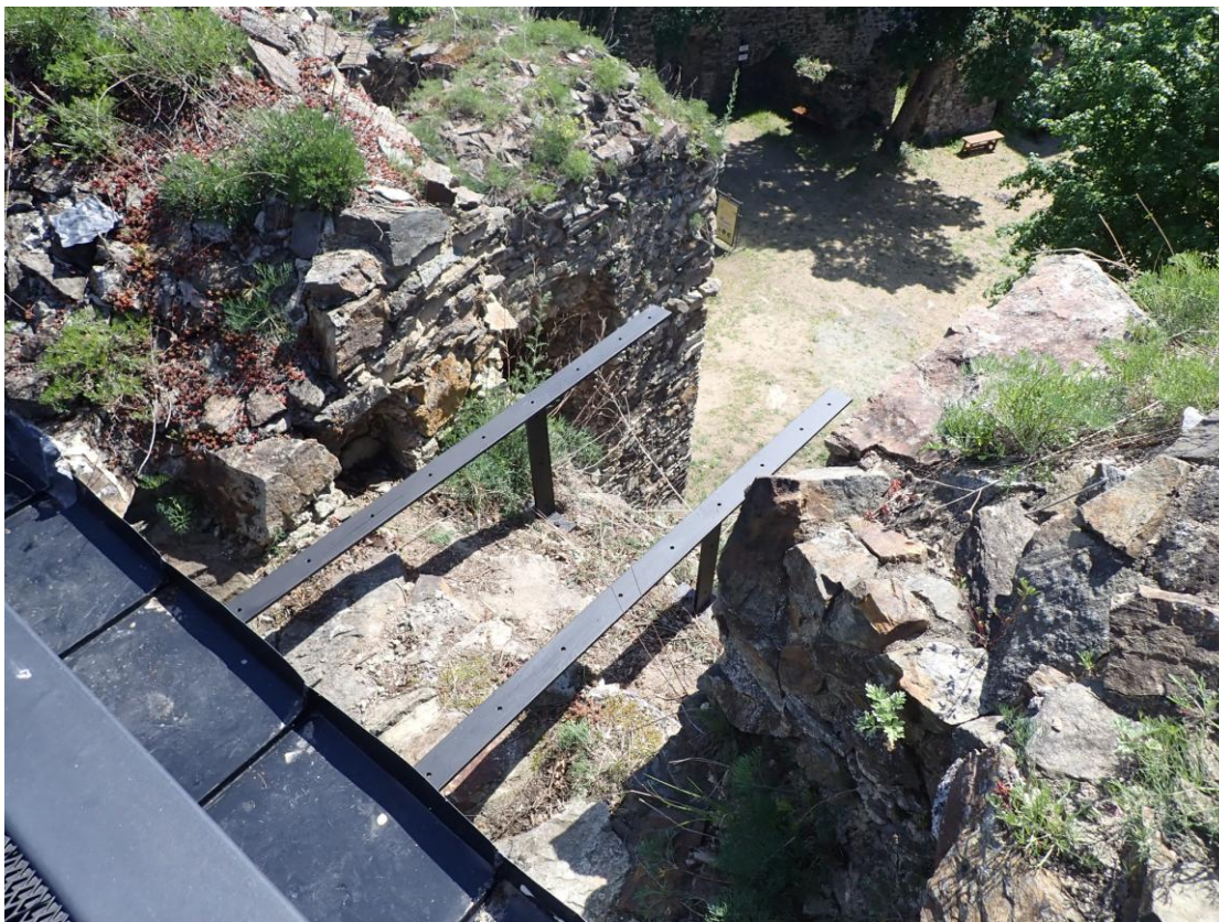
Demontované zastřešení zdiva je tvořeno dvojicí pásovin s bedněním a krycím plechem.
